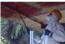
**incapsulamento:** l'amianto solo se in matrice compatta, viene trattato con prodotti penetranti o ricoprenti che impediscono la dispersione di fibre
