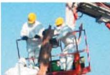
**rimozione:** l'amianto trattato precedentemente, viene rimosso dalla sede utilizzando specifici accorgimenti
